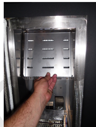
Foto 2: Colocar chapa metálica
